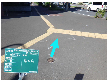
LEE厚別中央の横から9/25配水管を地中に埋設していきます。
