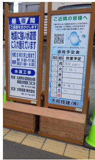
現地に週間工程表を設置してます
